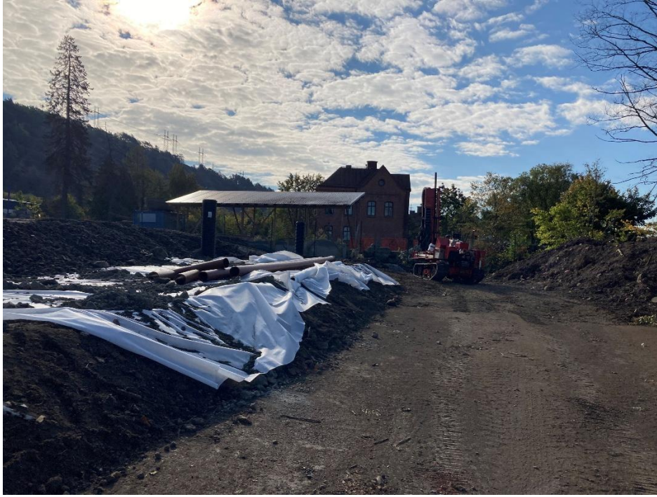
Översiktsbild, södra delen av fastigheten.
